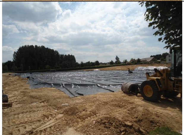
Folie klaar voor aanleggen drainage
